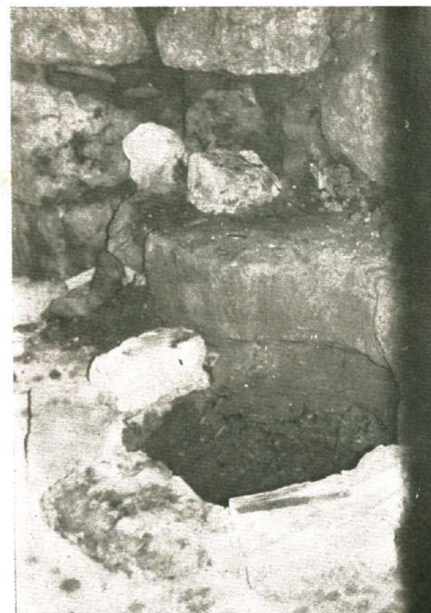
Fig. 9 - S. MARIA MAGGIORE DI SIPONTO: pozzetto nel piano di fondazione.
